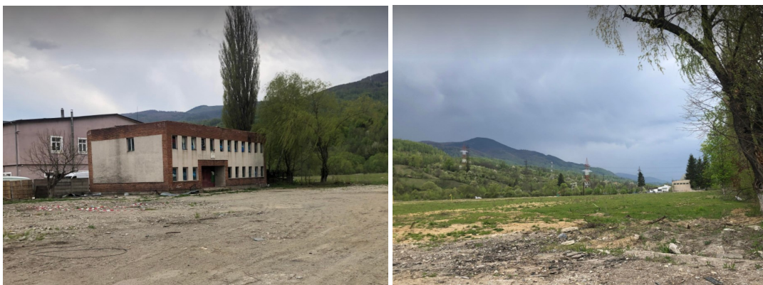
Fig. 3. Mina Uricani – clădiri abandonată, resturi de materiale de construcție
