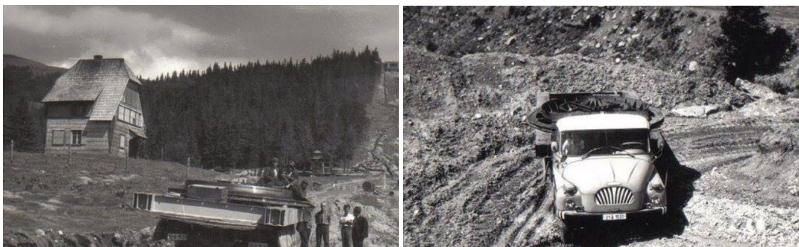
Fig. 2. Transport de materiale pentru construcția telescaunul Parâng (anii 1972-1973)
