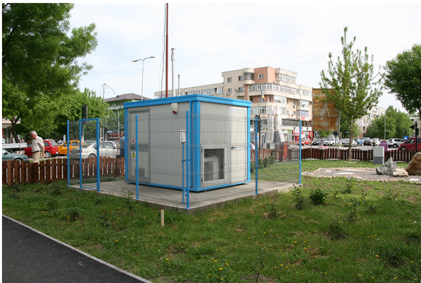
Fig. 1. Stația CL1 - Zona Orizont
