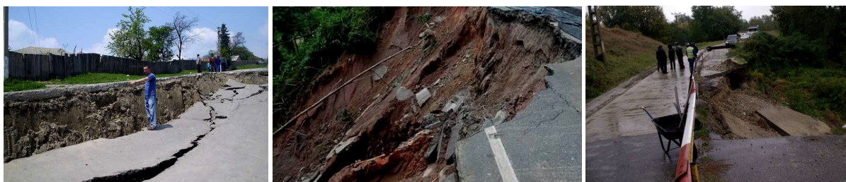
Fig. 3. Infrastructuri rutiere afectate de alunecări în zona Poiana Seciuri-Bustuchin
