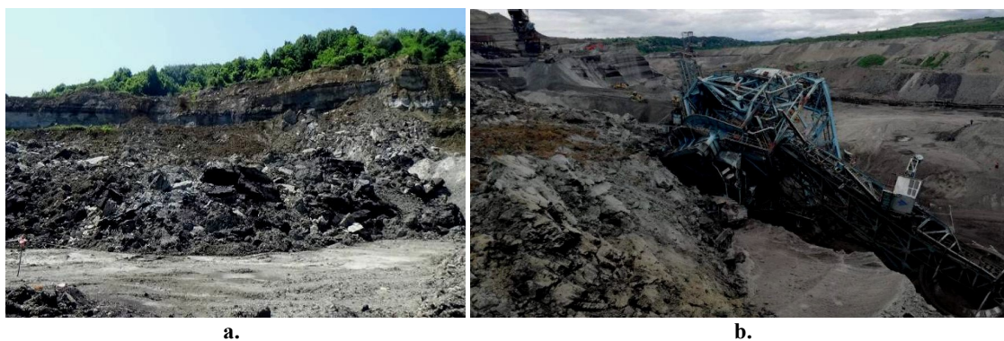
Fig. 3. a. Alunecarea din cariera Alunu din 2019 și b. excavatorul avariata [4]
