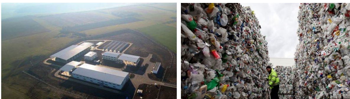
Fig. 2. Depozitul de deșeuri Bârcea Mare
