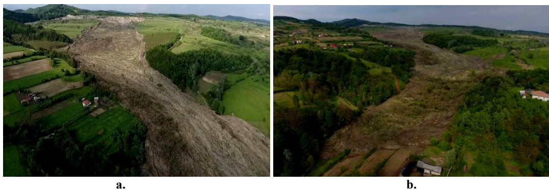
Fig. 2. Alunecarea haldei exterioare Berbești Vest (a. în 2017, imediat după producere; b. în 2019, relativ stabilizată și în curs de revegetare) [8]
