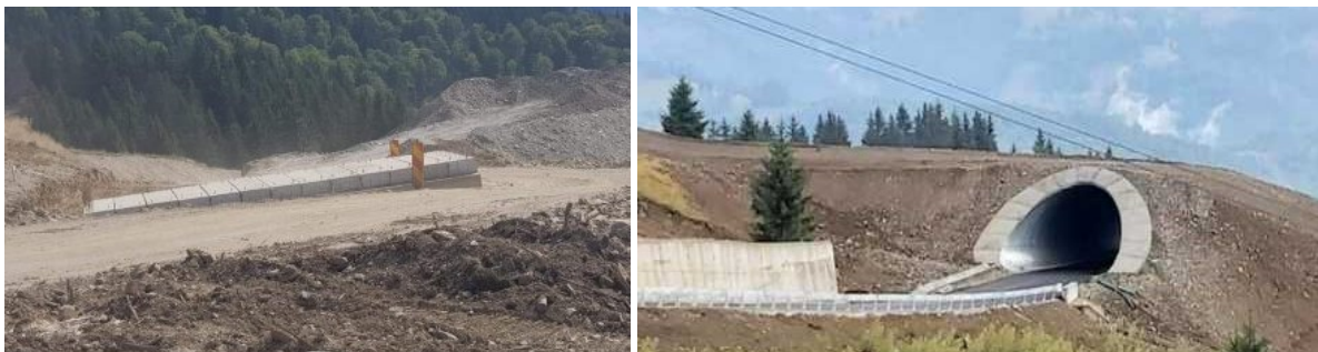
Fig. 3. Construcția zidurilor de sprijin și a primului tunel
